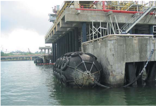
LNG Terminal \phi 3300 \times 6500L
