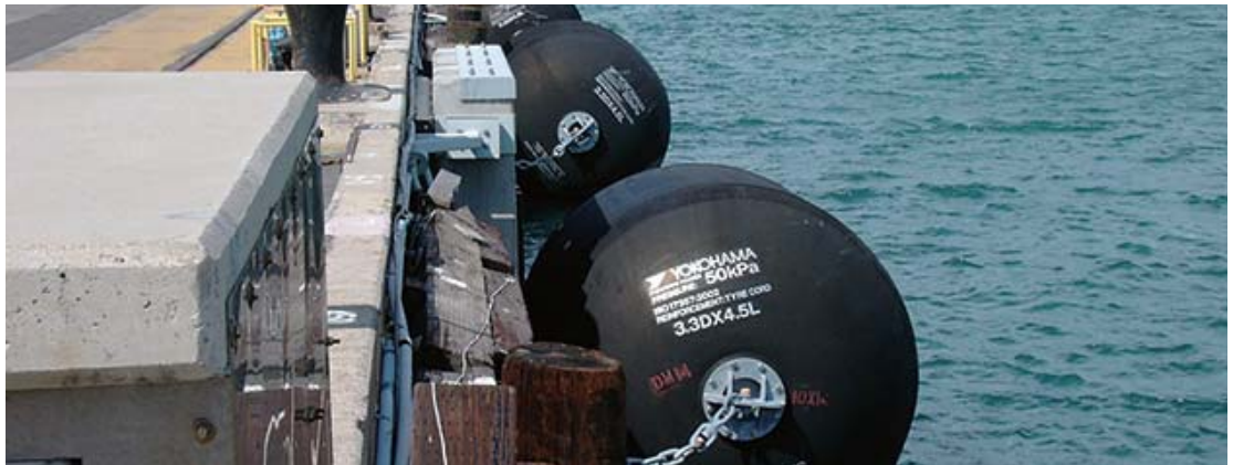
Terminal \phi 3300 \times 4500L
